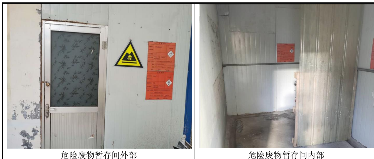
图 6.1-3 危险废物暂存间
