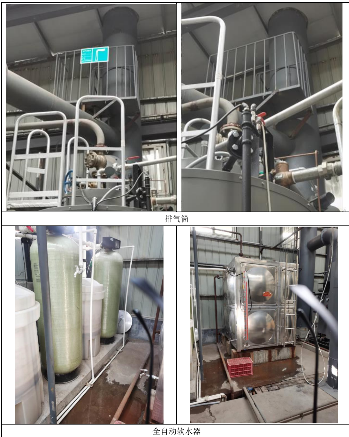
图 5.3-1 本项目建设现状照片
